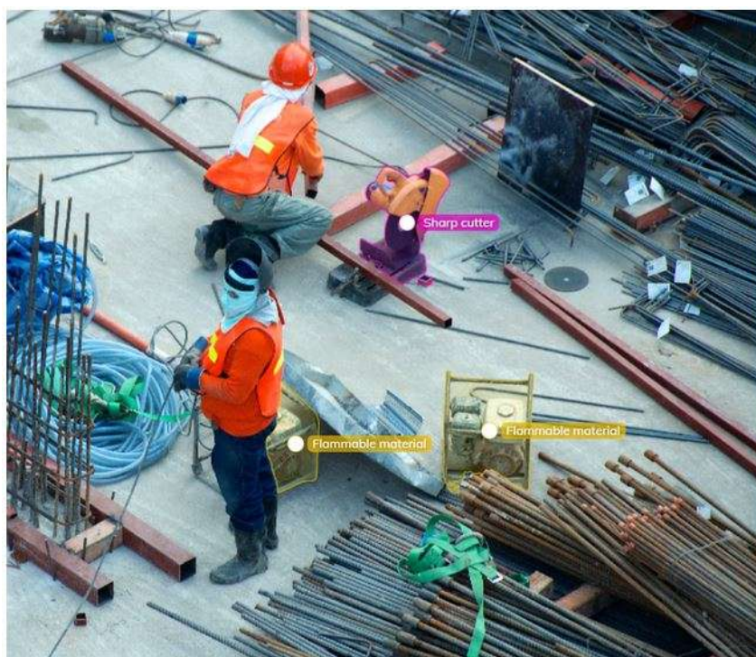
Рис. 1. Наблюдение искусственного интеллекта за рабочей зоной строительства
