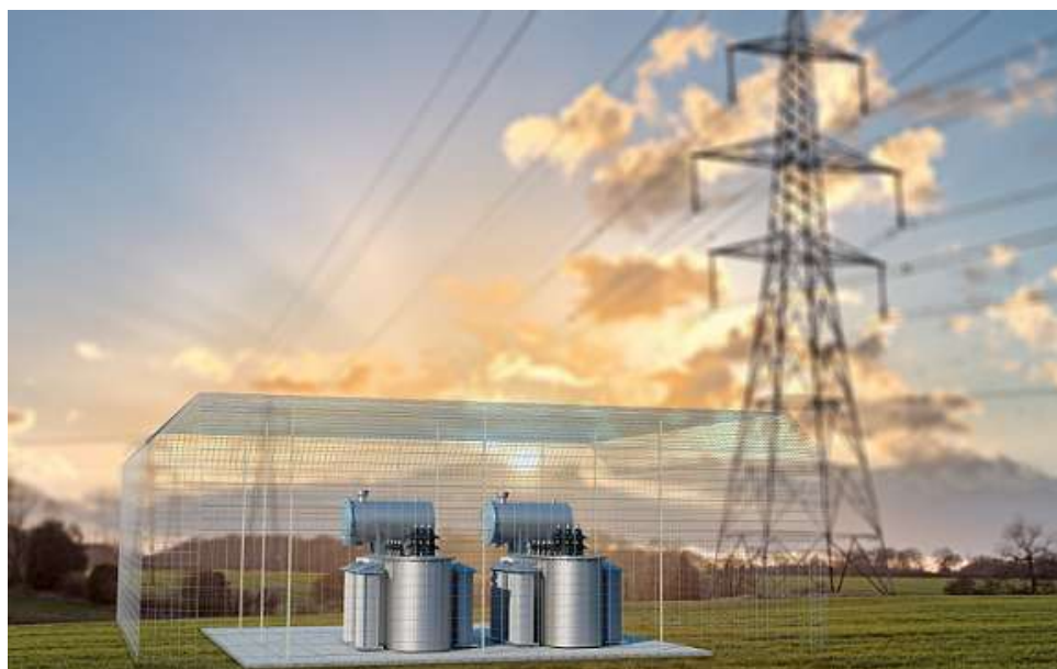
Рис. 5. Защитные сетки на резервуарах [6]
