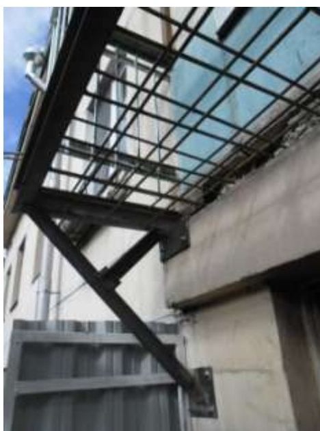
Рис. 3. Замена балконной плиты
