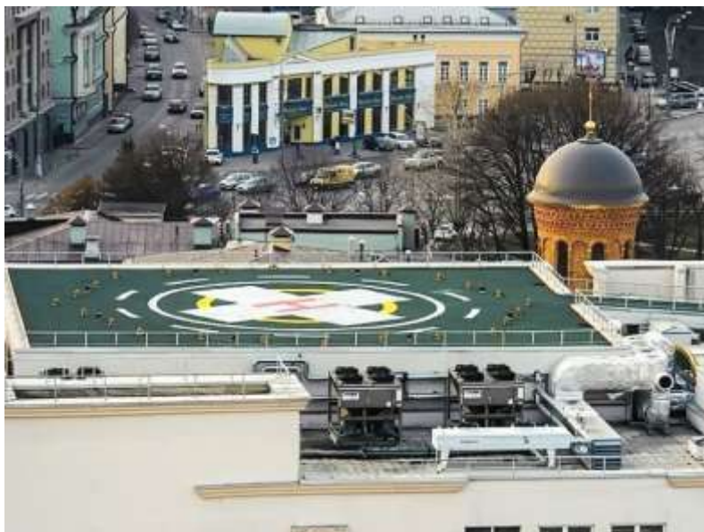
Рис. 2. Вертолетная площадка на крыше НИИ неотложной детской хирургии и травматологии, г. Москва
