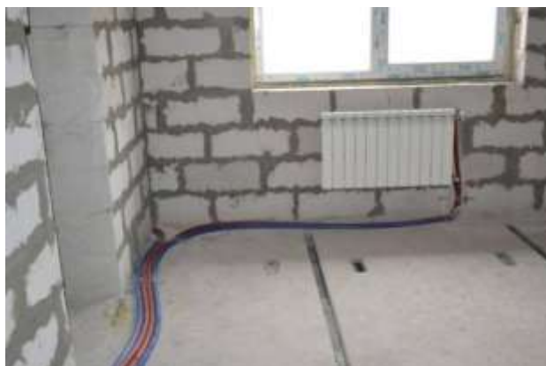
Рис. 1. Прокладка труб в доме
